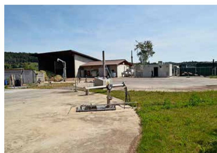
L'installation de biogaz des Müller, avec les digesteurs enterrés, passe presque inaperçue dans le paysage.
